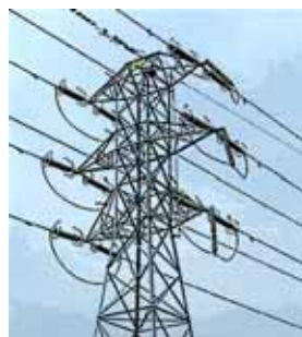
【送電線】 ・高さ測定 ・樹木との離隔測定
