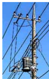
【配電線】 ・高さ測定 ・タルミ量測定
