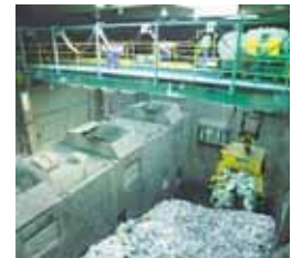
ゴミ焼却場などの 発火監視
