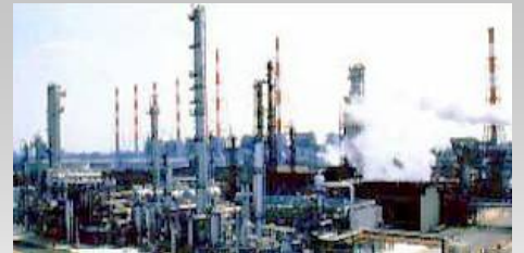
各種プラント設備
